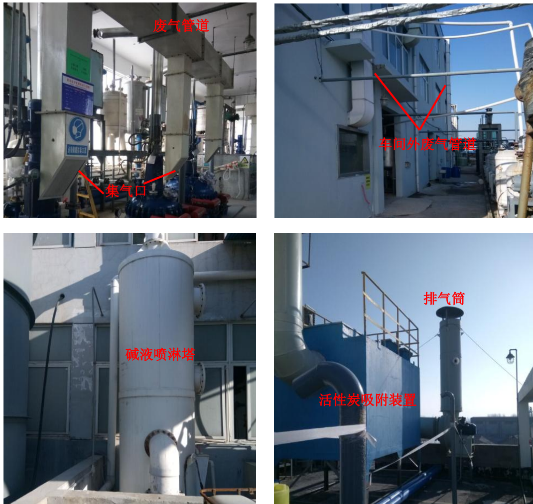
图 4.1-6 企业废气收集及治理措施现场图（部分）
