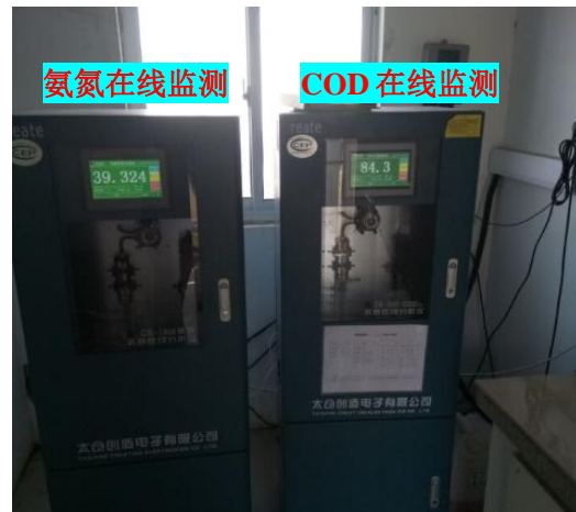
图 4.1-3 企业废水处理设施及在线监测设备现场图（部分）
